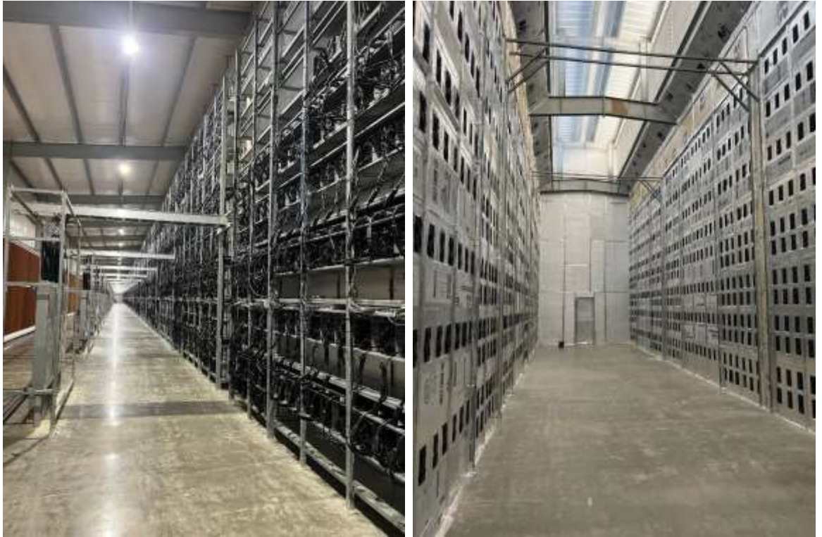
出典: グローバルX リサーチ - 左側の写真は換気扇を使う棟のASICの一行。ASICが熱を帯びた空気を排出する際、この通路が空気の通り道となる。右側の写真は、左側の写真に写っている壁の背面。熱を帯びた空気は屋外に出る前に、絶縁された熱の通り道へ排出される。
