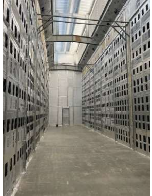
출처: Global X 리서치 - 좌측 사진은 팬으로 냉각되는 시설에 있는 일렬로 배치된 ASIC를 보여줍니다. 이러한 복도는 각 ASIC가 공기를 빨아들일 때 바람 터널 역할을 합니다. 우측 사진은 좌측 사진에 있는 벽 뒤의 모습을 보여줍니다. 뜨거운 공기는 단열된 열 통로를 통해 빌딩 밖으로 배출됩니다.
