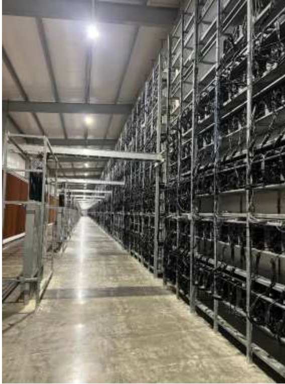
출처: Global X 리서치 - 좌측 사진은 팬으로 냉각되는 시설에 있는 일렬로 배치된 ASIC를 보여줍니다. 이러한 복도는 각 ASIC가 공기를 빨아들일 때 바람 터널 역할을 합니다. 우측 사진은 좌측 사진에 있는 벽 뒤의 모습을 보여줍니다. 뜨거운 공기는 단열된 열 통로를 통해 빌딩 밖으로 배출됩니다.
